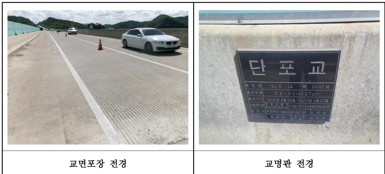
【사진 28.3.19】 교면포장 전경
