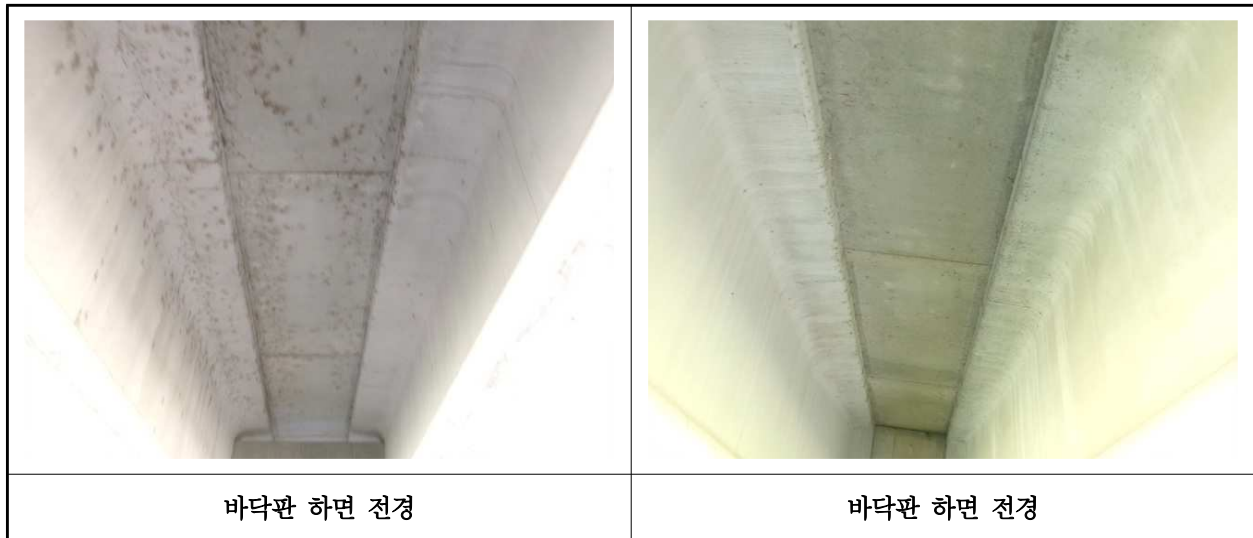
【사진 28.3.2】 바닥판하면 전경
