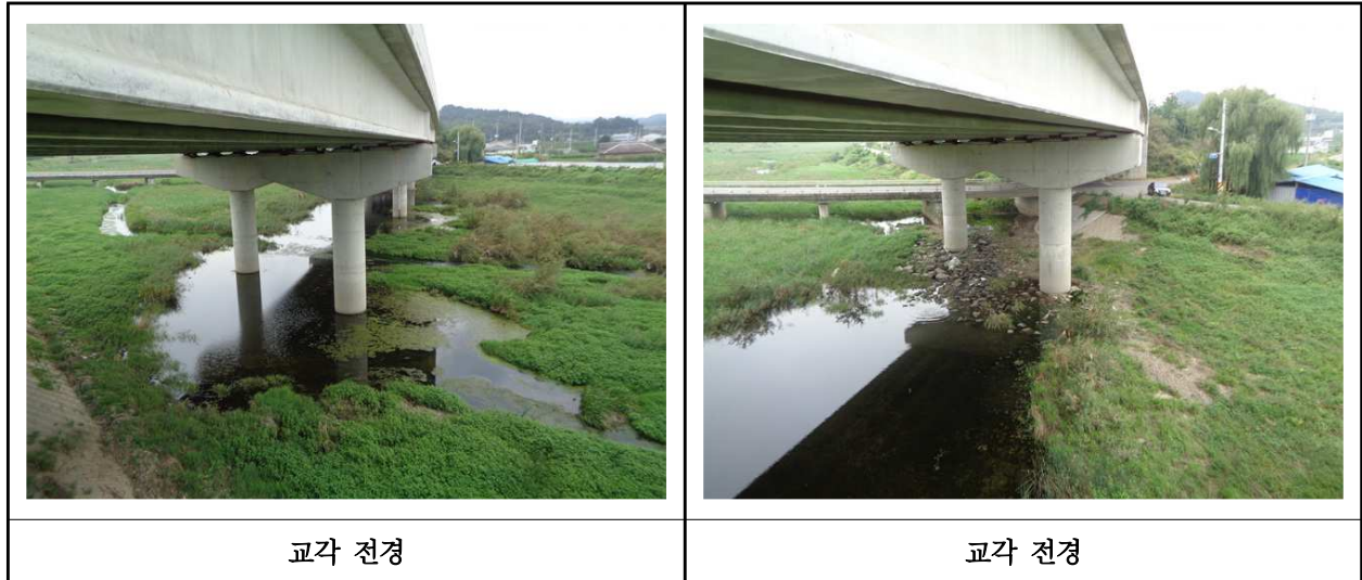
【사진 28.3.33】 교각 전경
