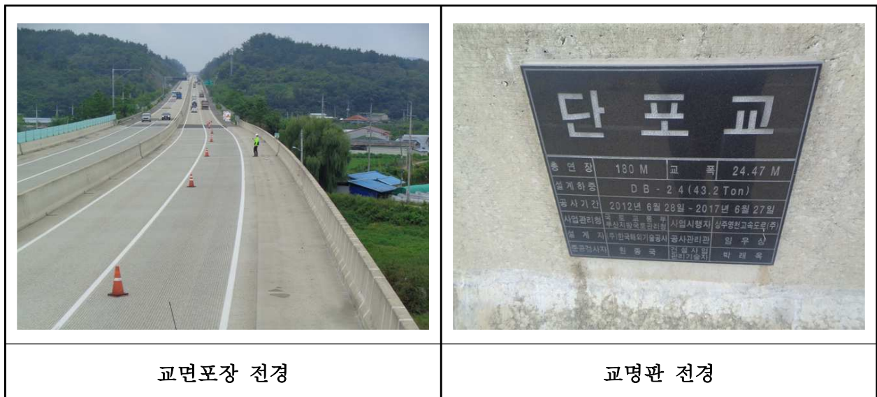
【사진 28.3.42】 교면포장 전경
