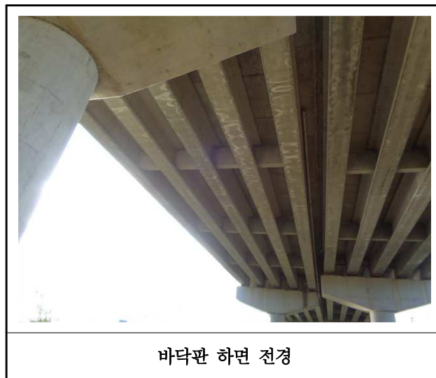
【사진 28.3.25】 바닥판하면 전경
