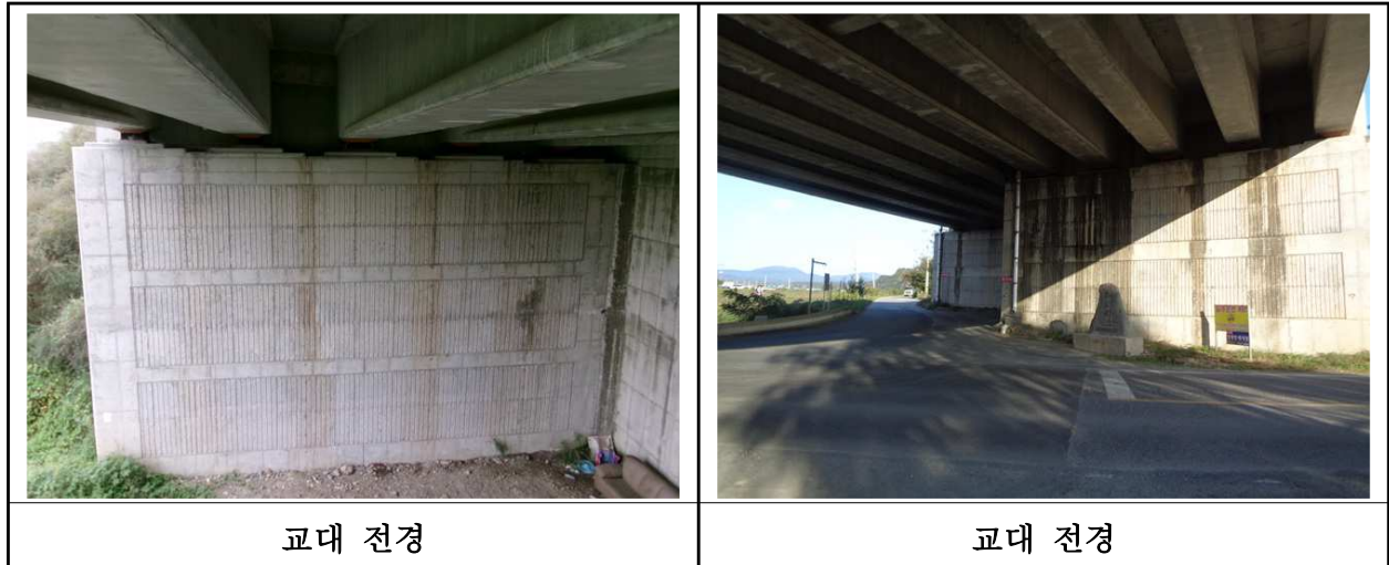
【사진 28.3.31】 교대 전경
