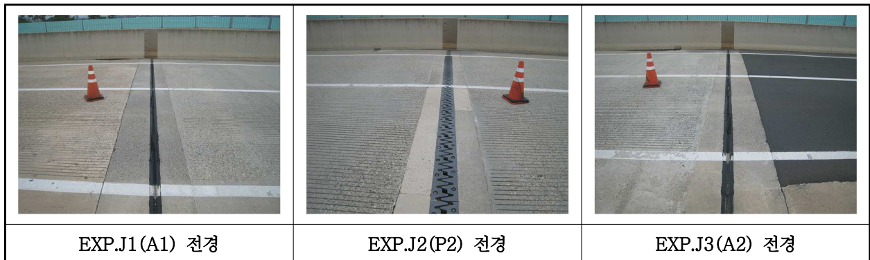
【사진 28.3.39】 신축이음장치 전경
