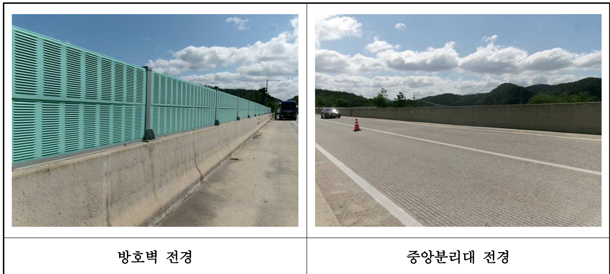
【사진 28.3.23】 방호벽 및 중앙분리대 전경
