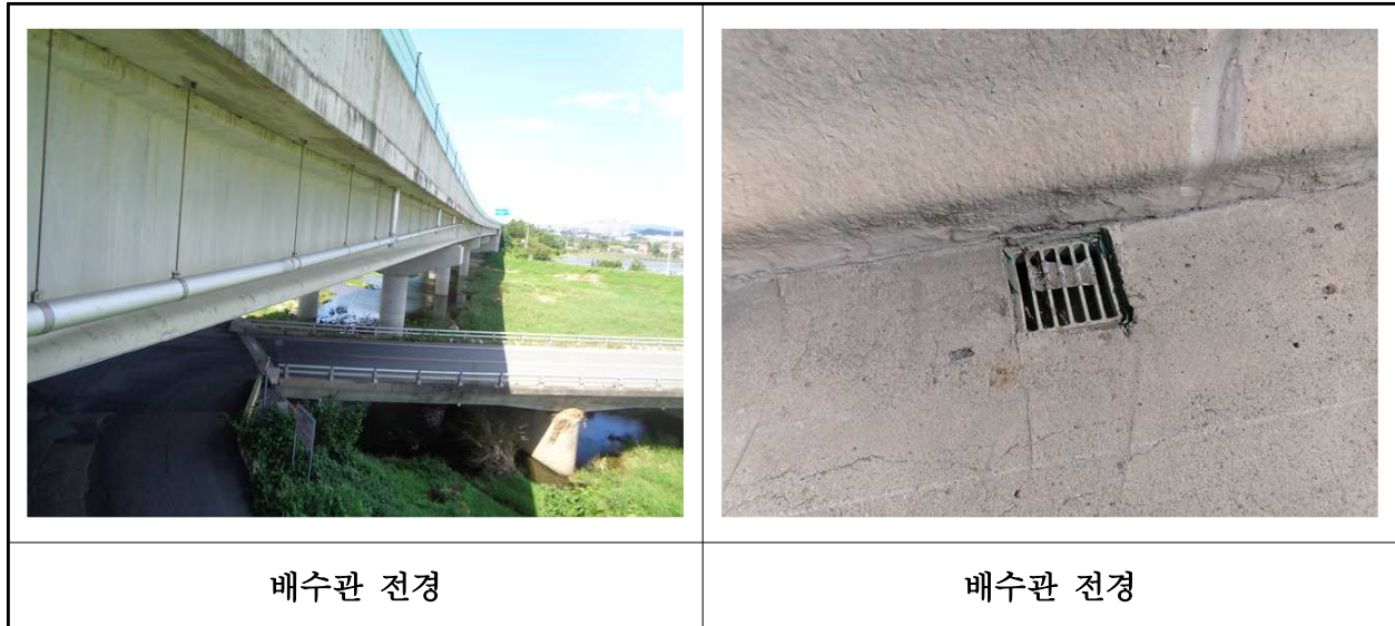
【사진 28.3.21】 배수시설 전경
