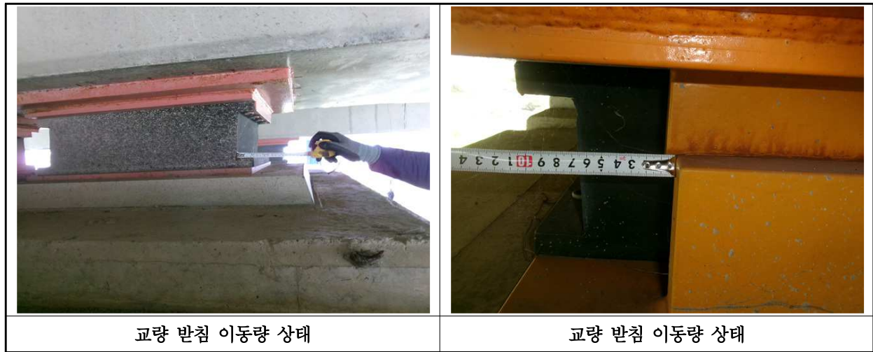
【사진 28.3.15】 교량받침 이동량 측정
