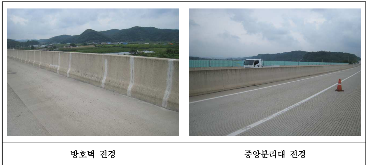
【사진 28.3.46】 방호벽 및 중앙분리대 전경
