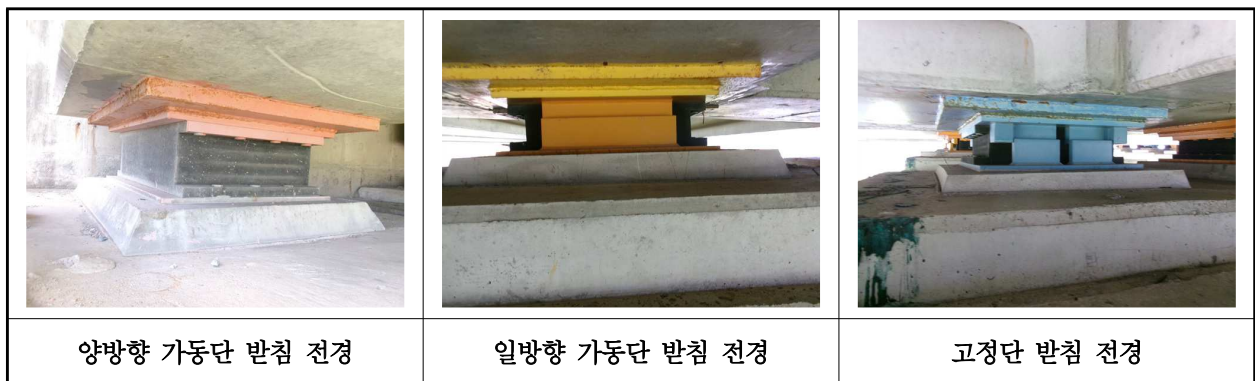
【사진 28.3.12】 교량반침 전경
