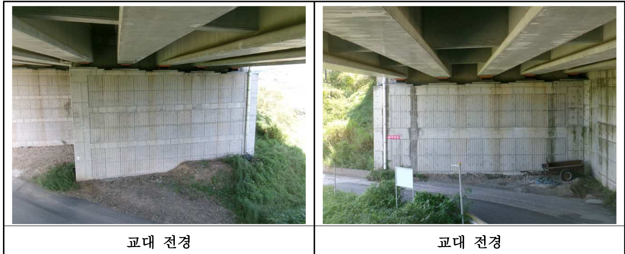
【사진 28.3.8】 교대 전경
