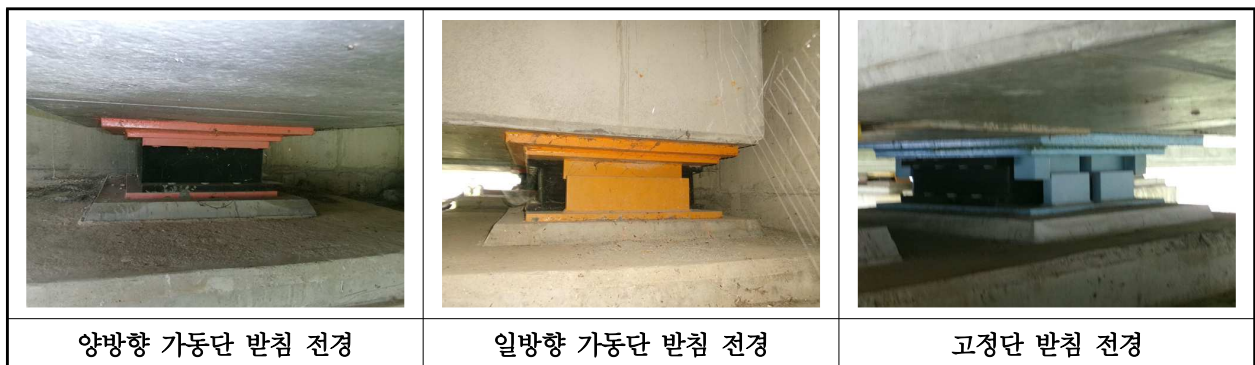
【사진 28.3.35】 교량반침 전경
