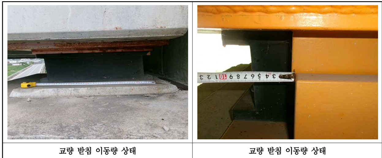
【사진 28.3.38】 교량받침 이동량 측정
